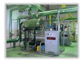
В качестве основного оборудования паровых автоматизированных котельных **AMELIN** применяются парогенераторы производства **AMELIN** Industry единичной мощностью от 1 до 100 т/ч и выше.
