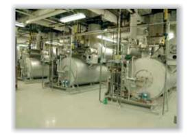
Полностью автоматизированные котельные **AMELIN** работают без постоянного присутствия обслуживающего персонала, все сигналы подаются на пульт оператора и на центральный диспетчерский пульт. Возможна интеграция в существующую общезаводскую АСУ.
