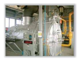
Водогрейные котельные **AMELIN** предназначены для автоматической работы и могут эксплуатироваться без постоянного присутствия обслуживающего персонала. Необходимая информация выводится на щит сигнализации, устанавливаемый в операторной котельной, а общий аварийный сигнал или группа сигналов может передаваться по системе цифровой диспетчеризации на рабочую станцию оператора.
